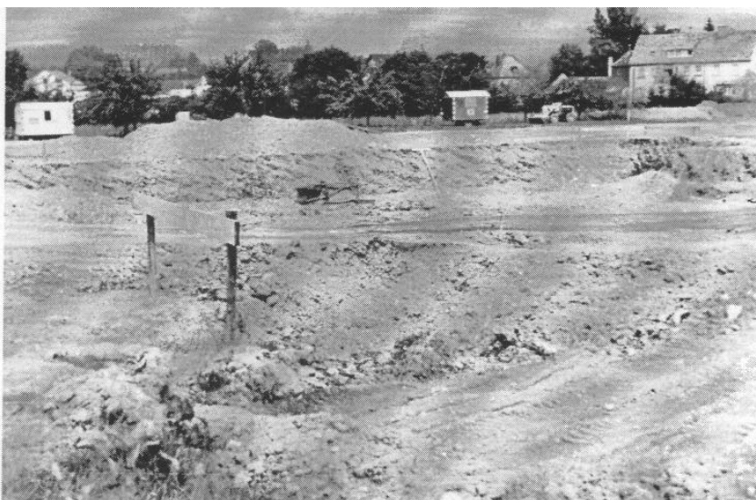
Erdaushub Verbandsschule im Juli 1970
