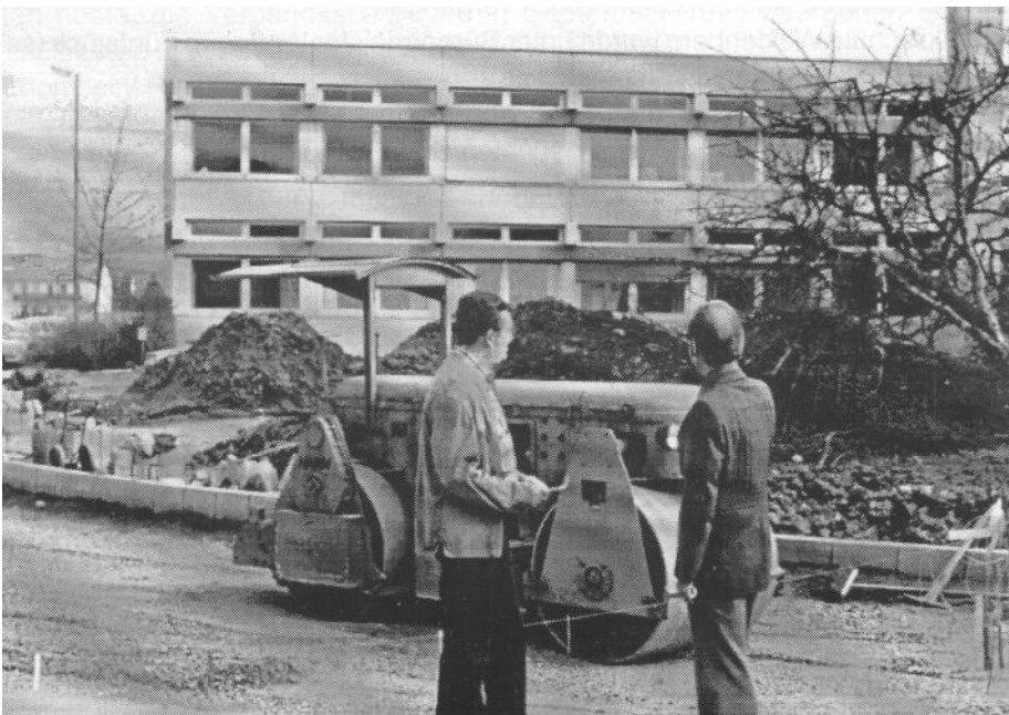
Kurz vor der Fertigstellung
