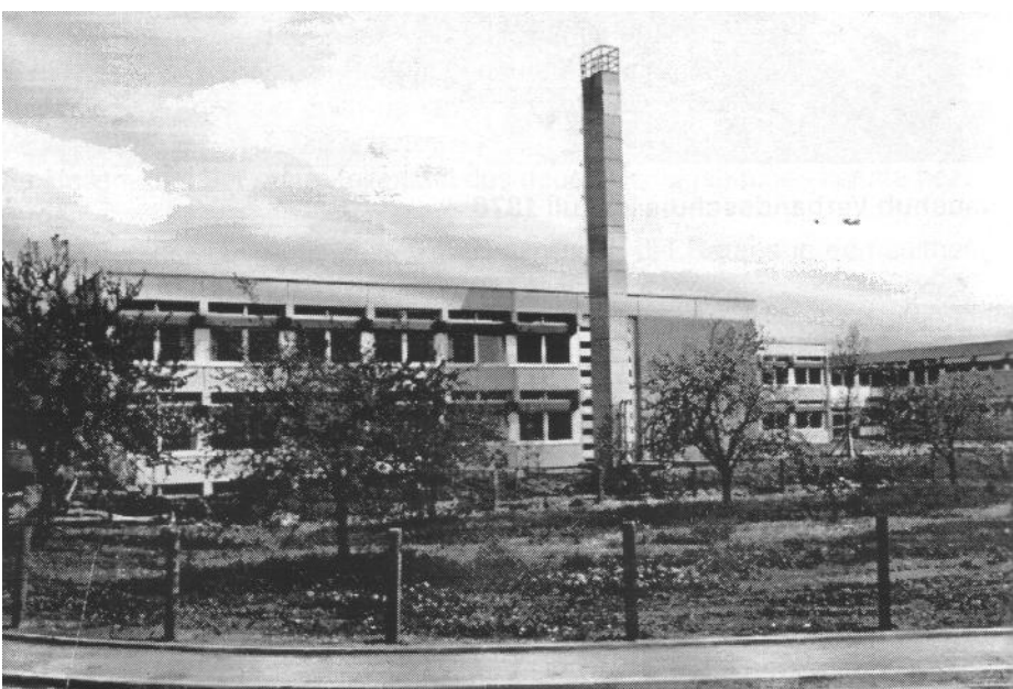
Blick von der Eichenstraße auf den Hauptbau. Der Anbau der Zeilen 3 und 4 fehlt hier noch.
